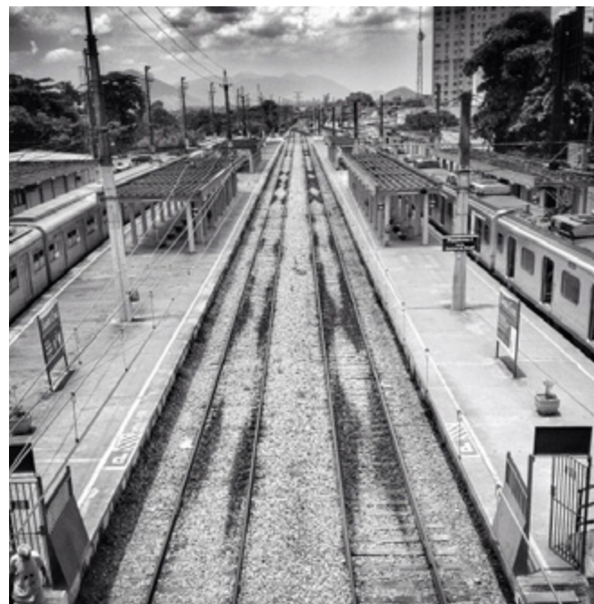
Estação de trem terminal Santa Cruz.
