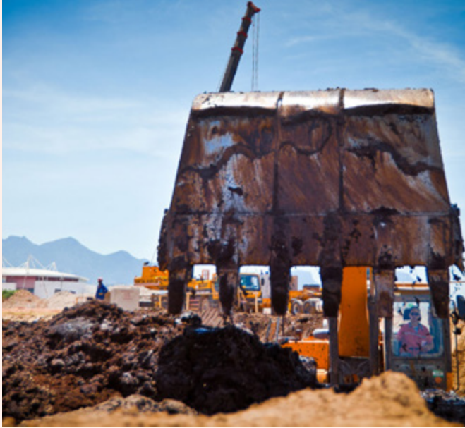
Obras do complexo do Parque Olímpico, na Zona Oeste do Rio.
